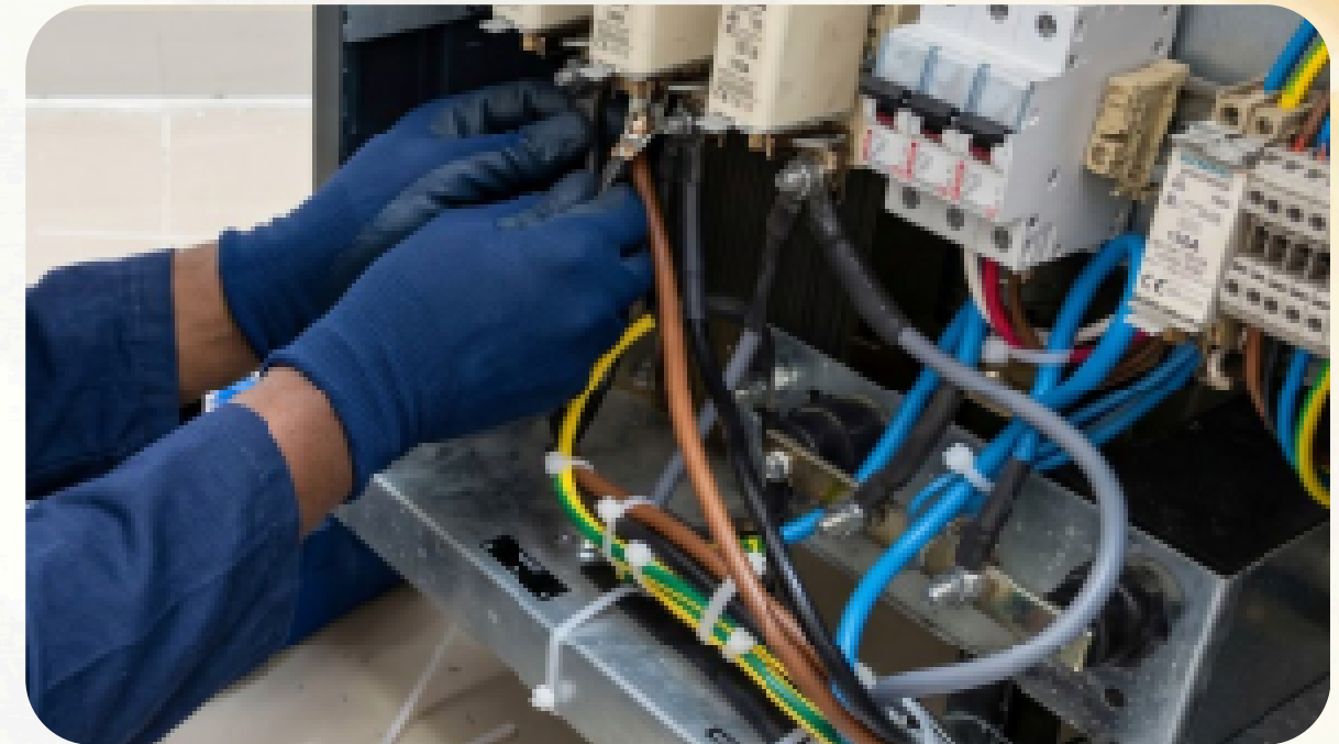
Banco SOL – Fornecimento e aplicação de contador – Lubango
