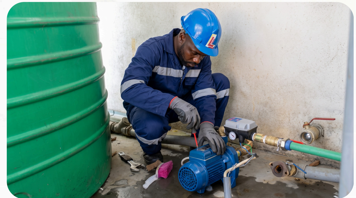
BFA – Fornecimento e aplicação de bomba hidropressora – Lubango
