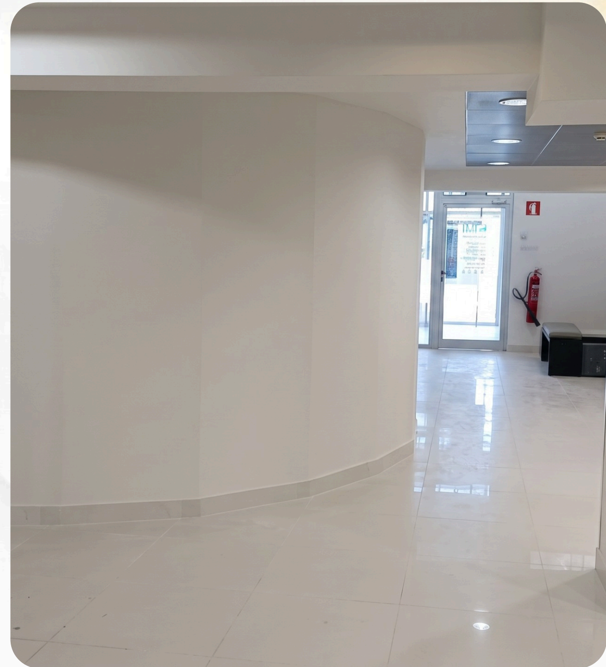
BAI- Construção de parede - Lubango
