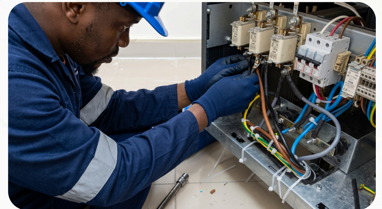
BFA - Reparação de estabilizador - Ondjiva
