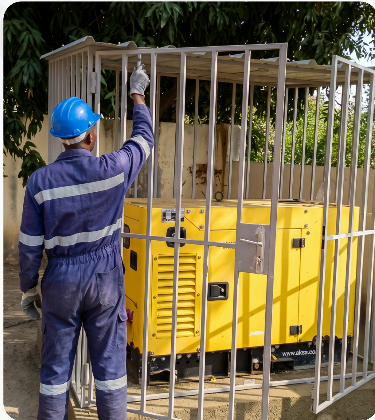
Del. Provincial da Justiça - Construção de base para gerador - Quipungo
