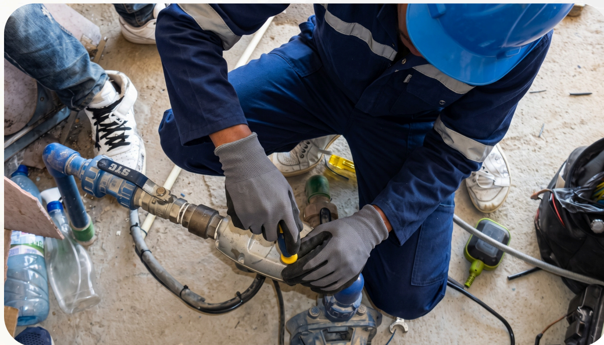
BFA – Fornecimento e aplicação de boia eléctrica – Lubango
