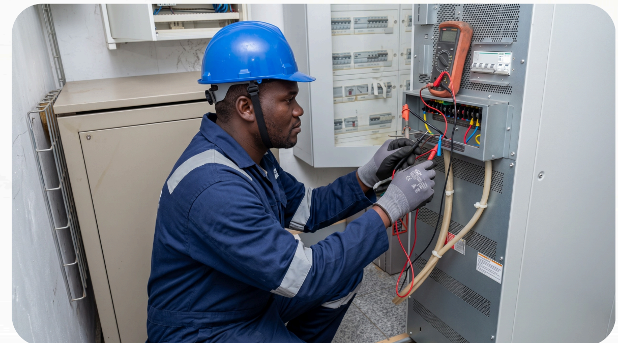
BFA - Montagem de UPS- Lubango
