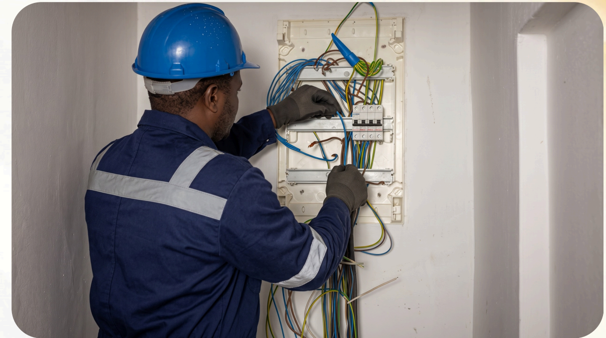
BPC - Reparação de quadro - Lubango
