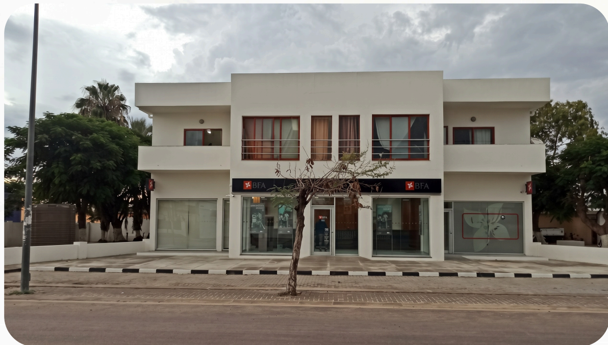
BFA - Pavimentação e redes de electricidade, dados e segurança - Ondjiva
