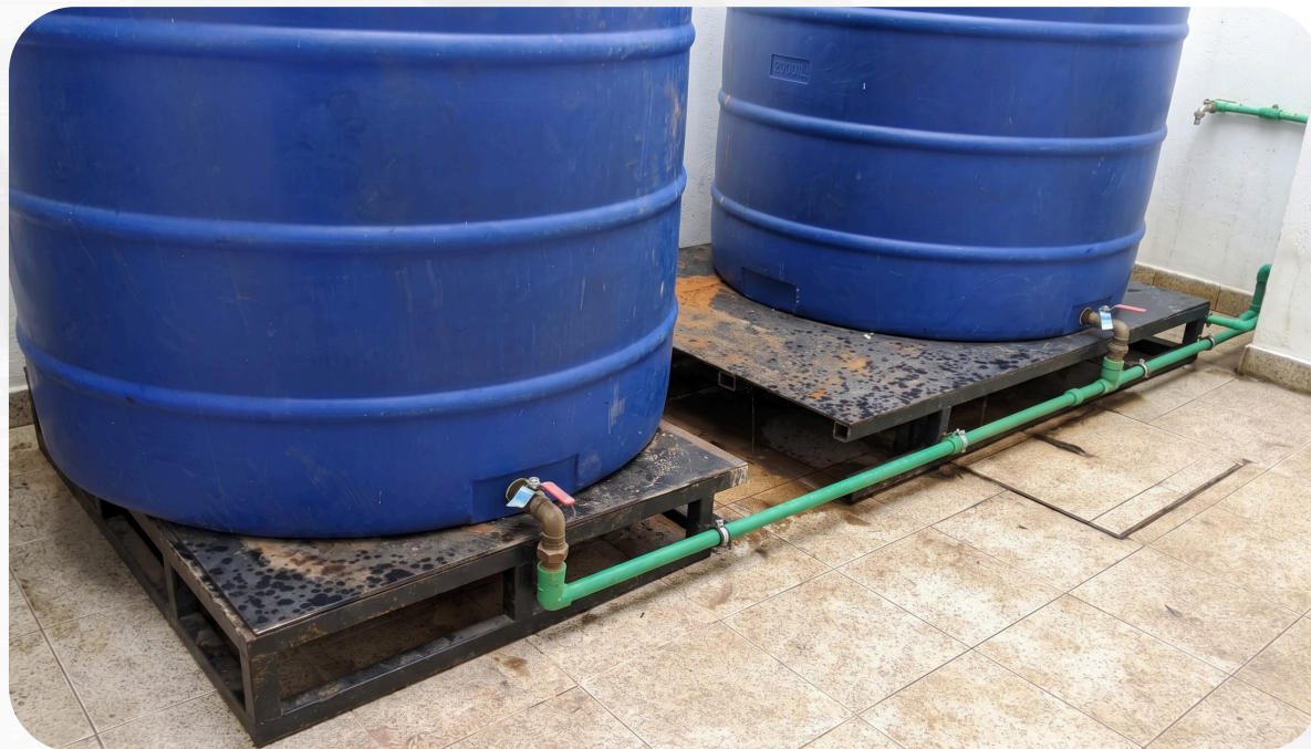
BAI – Reaplicação dos tanques, da canalização – Lubango
