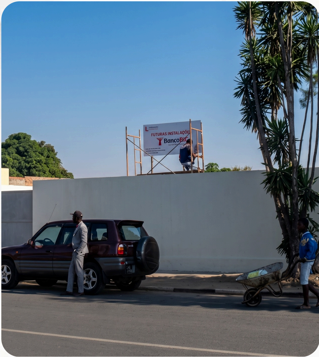
BIC – Muro de vedação – Quipungo
