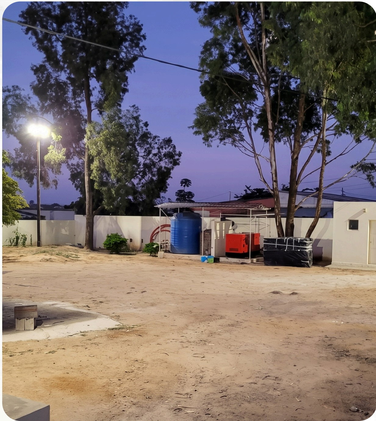
BIC - Muro de Vedação - Lubango
